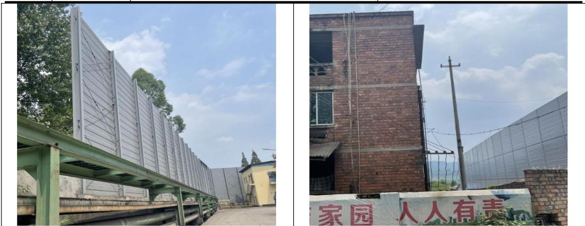
图 4-3 轧钢一车间噪声隔音屏障治理措施落实情况
